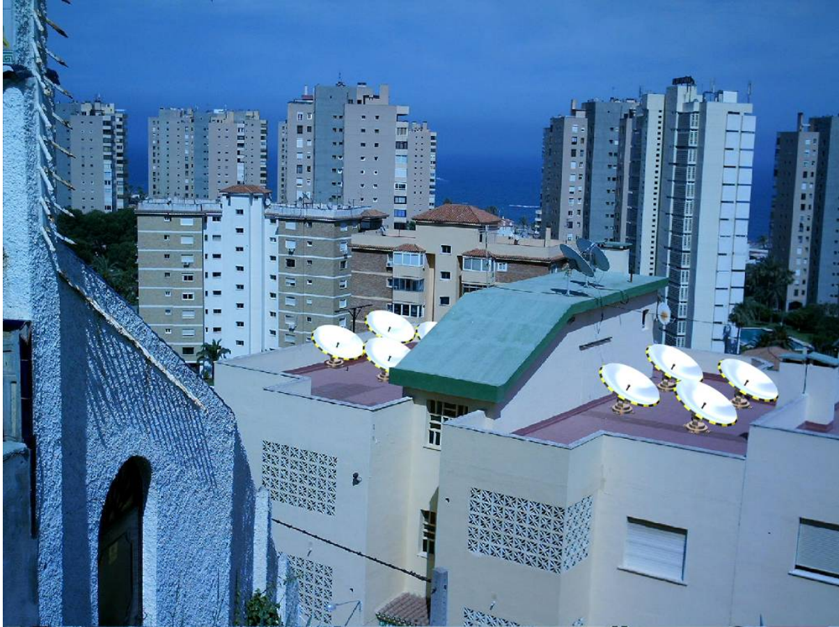
Fotografía 1.1. Instalación Solar Termovoltáica en Comunidad de Propietarios
